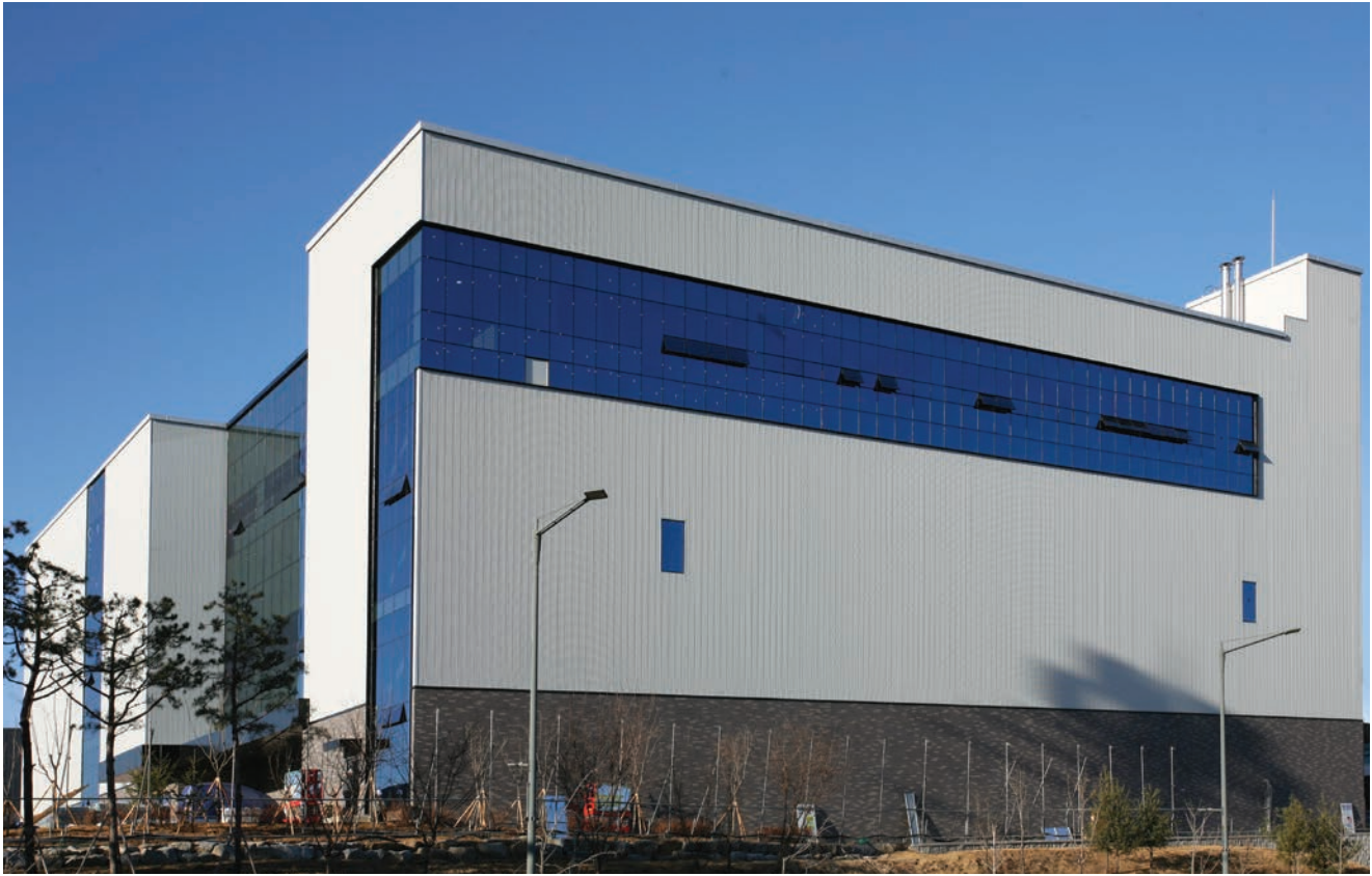
Cellark Bio 대지위치 : 원주시 지정면 신평리 | 건축용도 : 공장, 연구소 | 외부마감 : 루버강판 소골/백색
